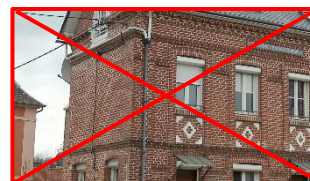
Mauvaise intégration des câbles électriques et des caissons de volets roulants
