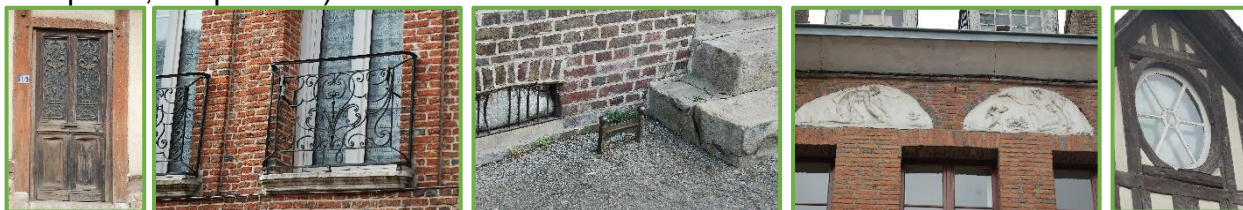
Exemples de détails architecturaux à conserver
