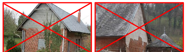
Exemple de parements non conformes à la règle (parpaings nus / faux moellons)
