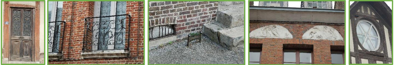
Exemples de détails architecturaux à conserver
