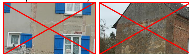
Exemples de couleurs non conformes à la règle (absence contraste enduit / maçonnerie)
