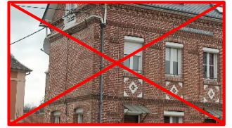
Mauvaise intégration des câbles électriques et des caissons de volets roulants
